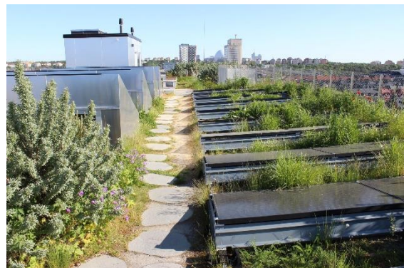
Referensbilder för tak med solceller: Urbio solcells/ grönt tak i Stockholm.
