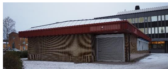
Gamla konditoriet är den byggnad som har kvar sin originalfasad.
