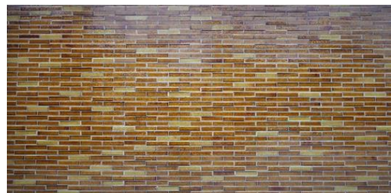
Ursprungligen fanns den gulglaserade fasadklinkern på alla byggnader vilket skapade ett enhetligt uttryck för Mjölkkuddens centrum. Idag finns den kvar på gamla konditoriet och på baksidan av centrumbebyggelsen.
