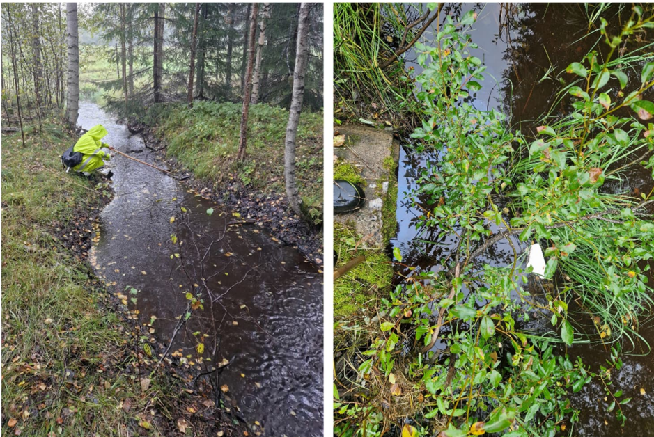
Figur 8. Det befintliga diket som avvattnar grannfastigheten norr om planområdet (vänster). Det befintliga diket igensatta utlopp nära kraftledningsgatan (höger). Foto vid regnig väderlek vid platsbesök 30 augusti 2024.
