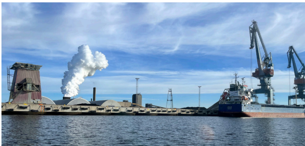
Figur 10 Vy över delar av hamnområden inom Svartön. På fotot ses bland annat släckmoln från släckning av koks. (foto Mia Persson, Luleå kommun).
