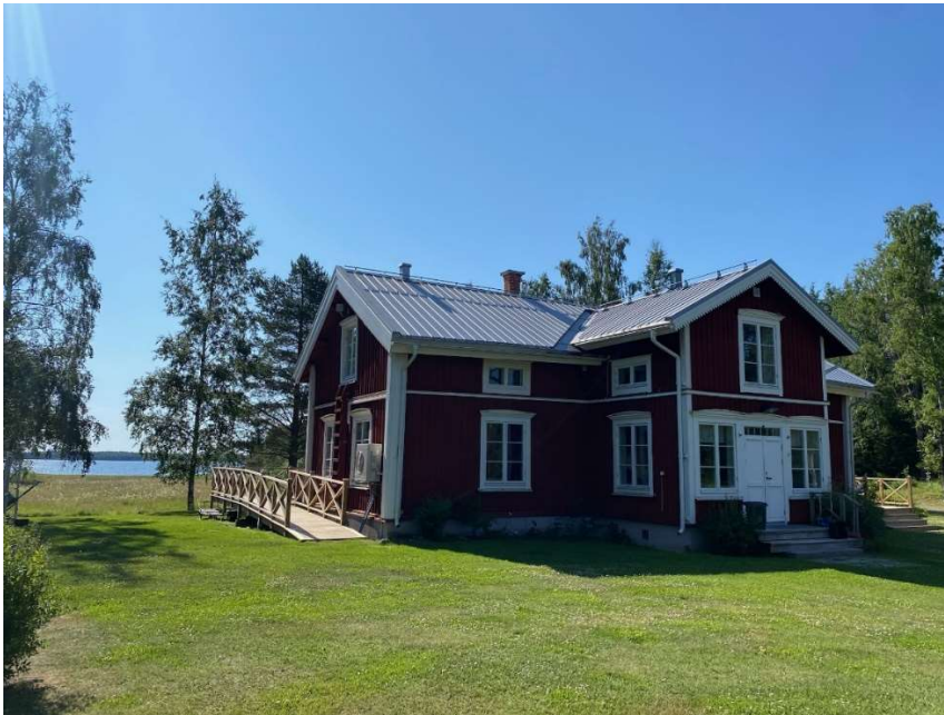
Området sett från norr
